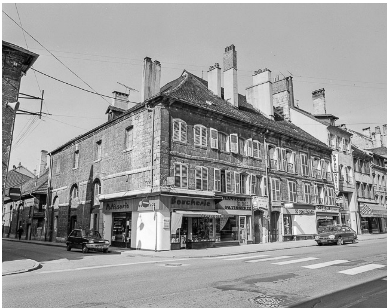
Maisons situées 5 à 11 rue de la République.
