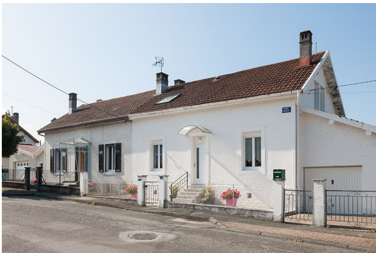
Maison jumelée vue de trois quarts droite.
