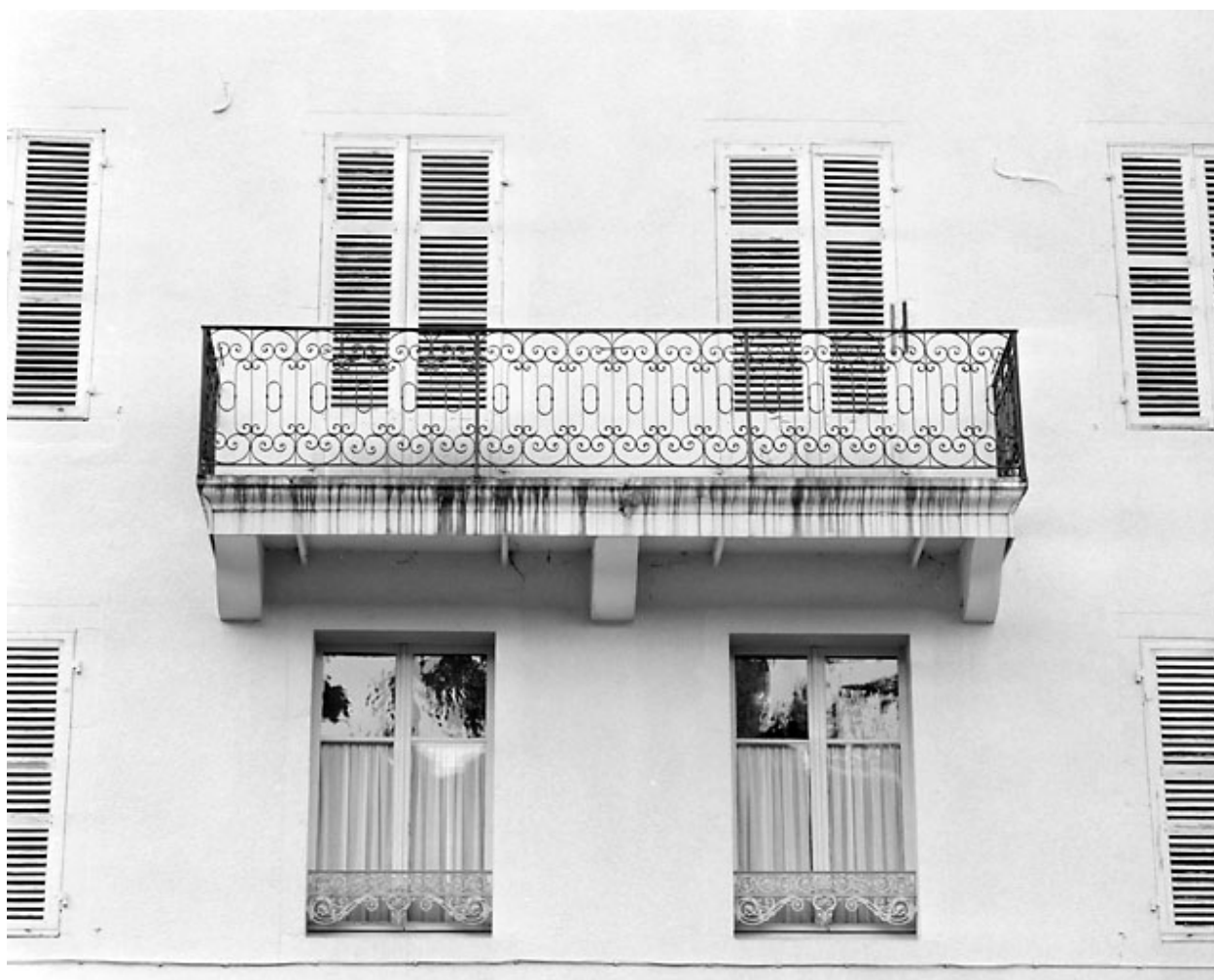
Façade postérieure : balcon.
