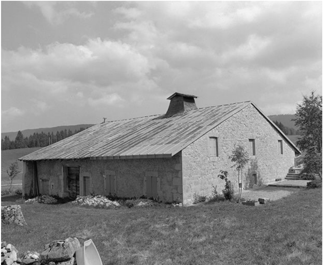
Façades postérieure et latérale droite.
