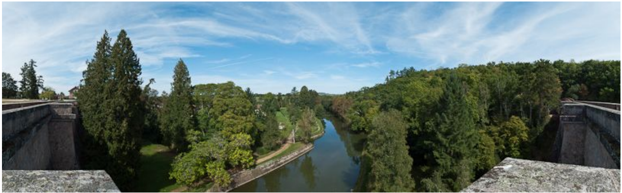
Vue générale de la rigole d'alimentation.
