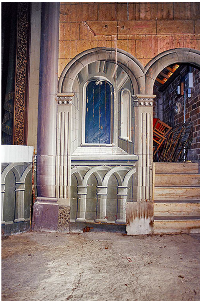
Fenêtre feinte côté cour, en 2002.
