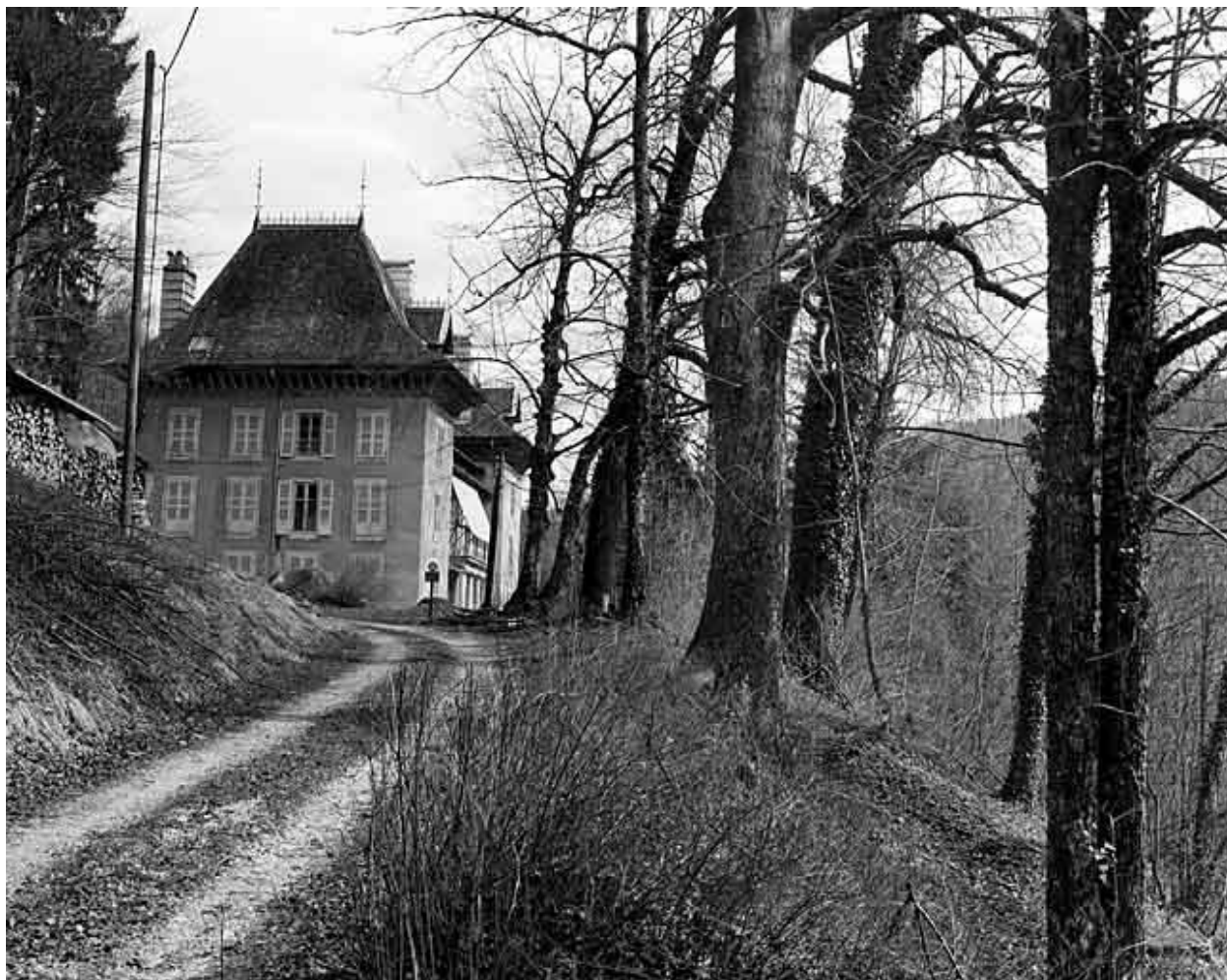
Vue d'ensemble rapprochée, depuis l'ouest.
