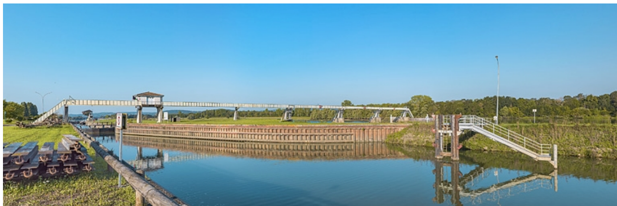
Tête amont de l'écluse.
