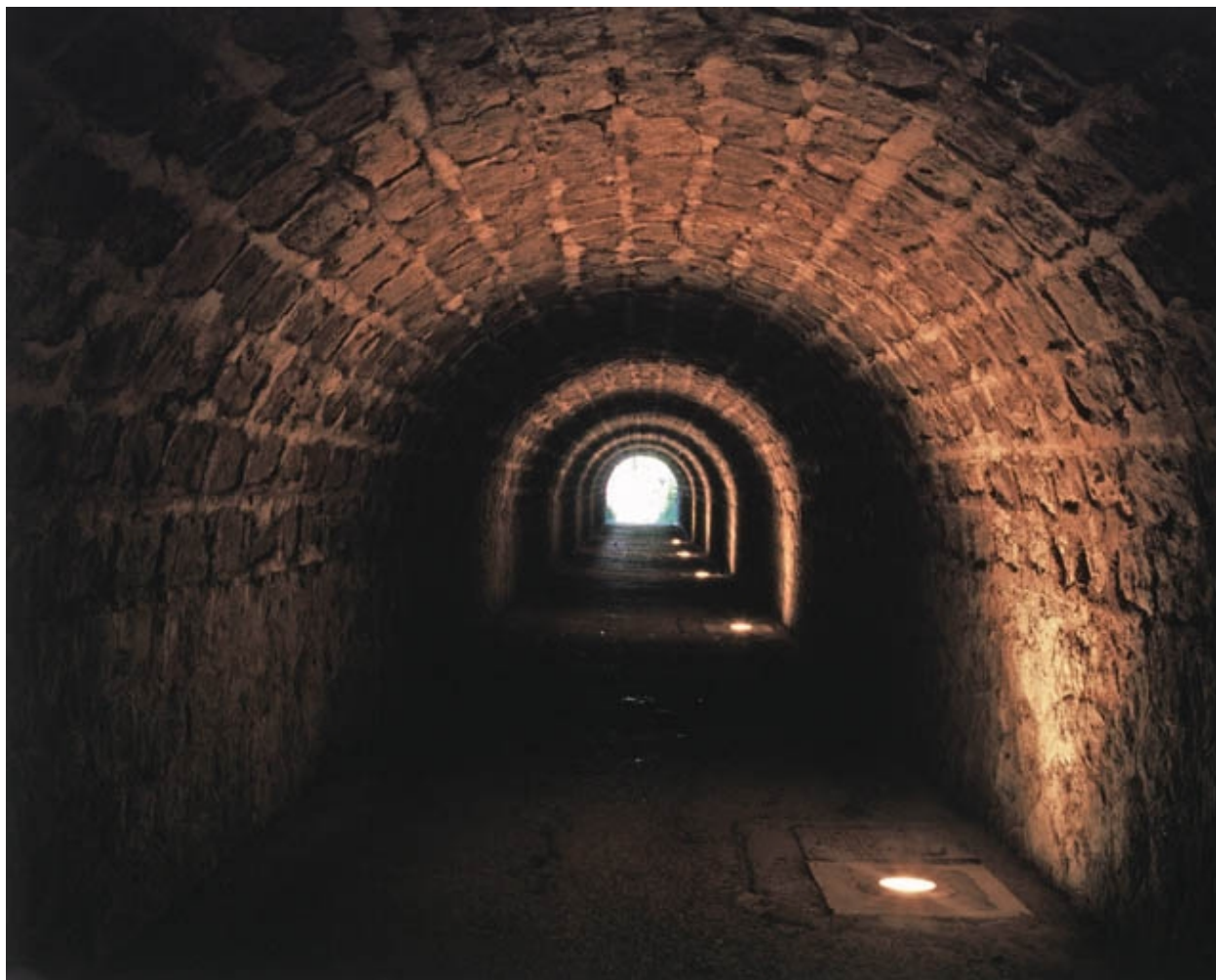
Passage souterrain (sous les voies) : intérieur.
