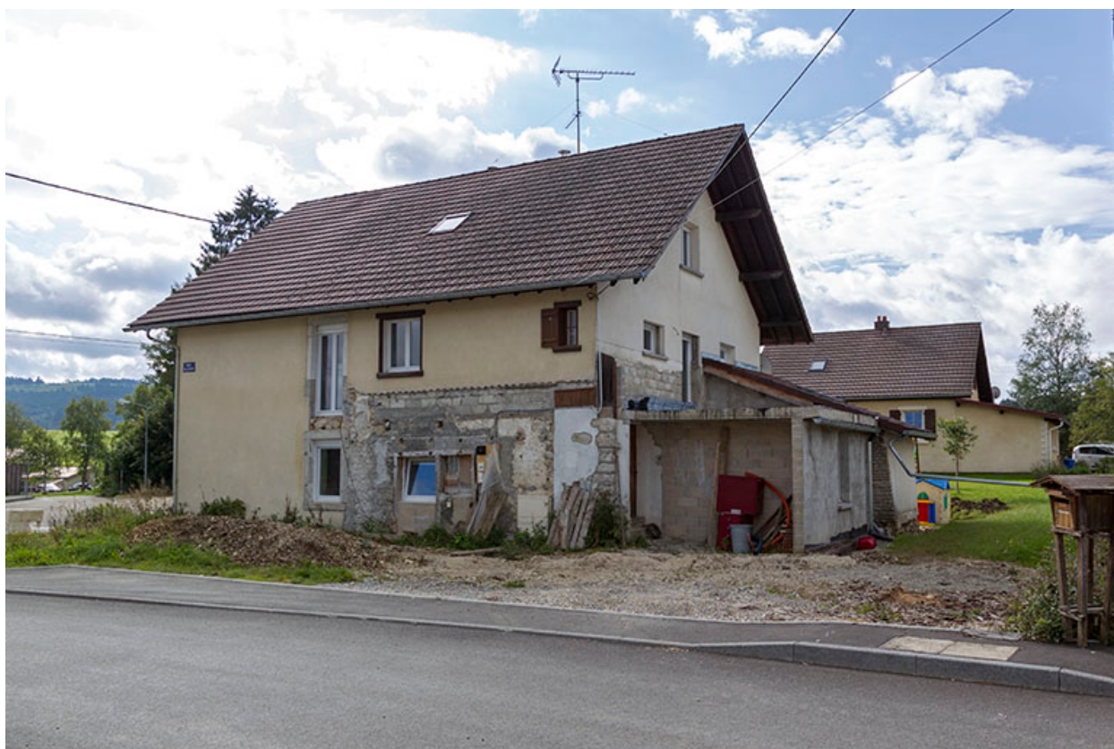
Bâtiment vu du nord.
