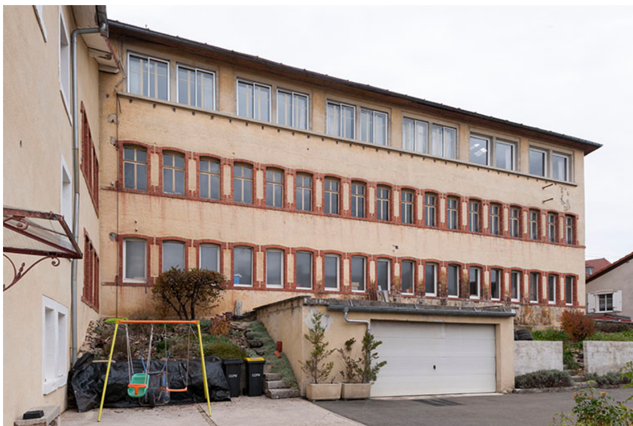
Usine : façade antérieure (sud).
