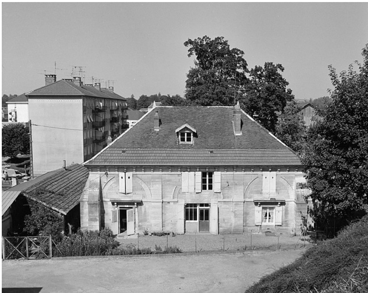
Façade antérieure, de face.
