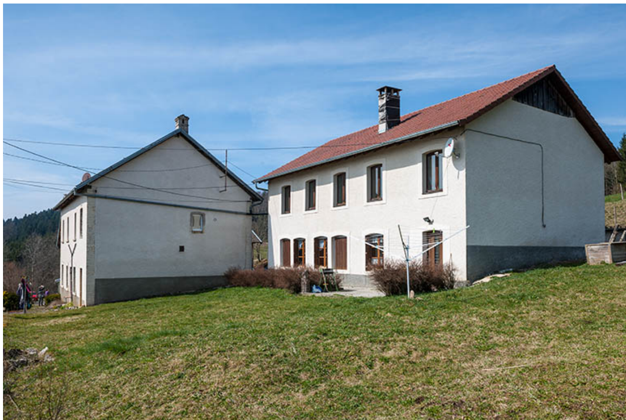
Atelier de fabrication et logement, côté vallée.
