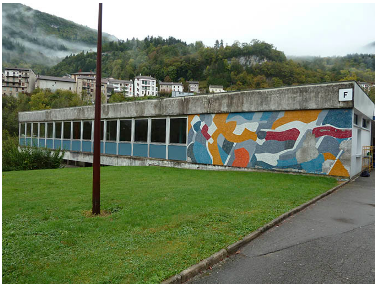
Vue générale, avant restauration du bâtiment.
