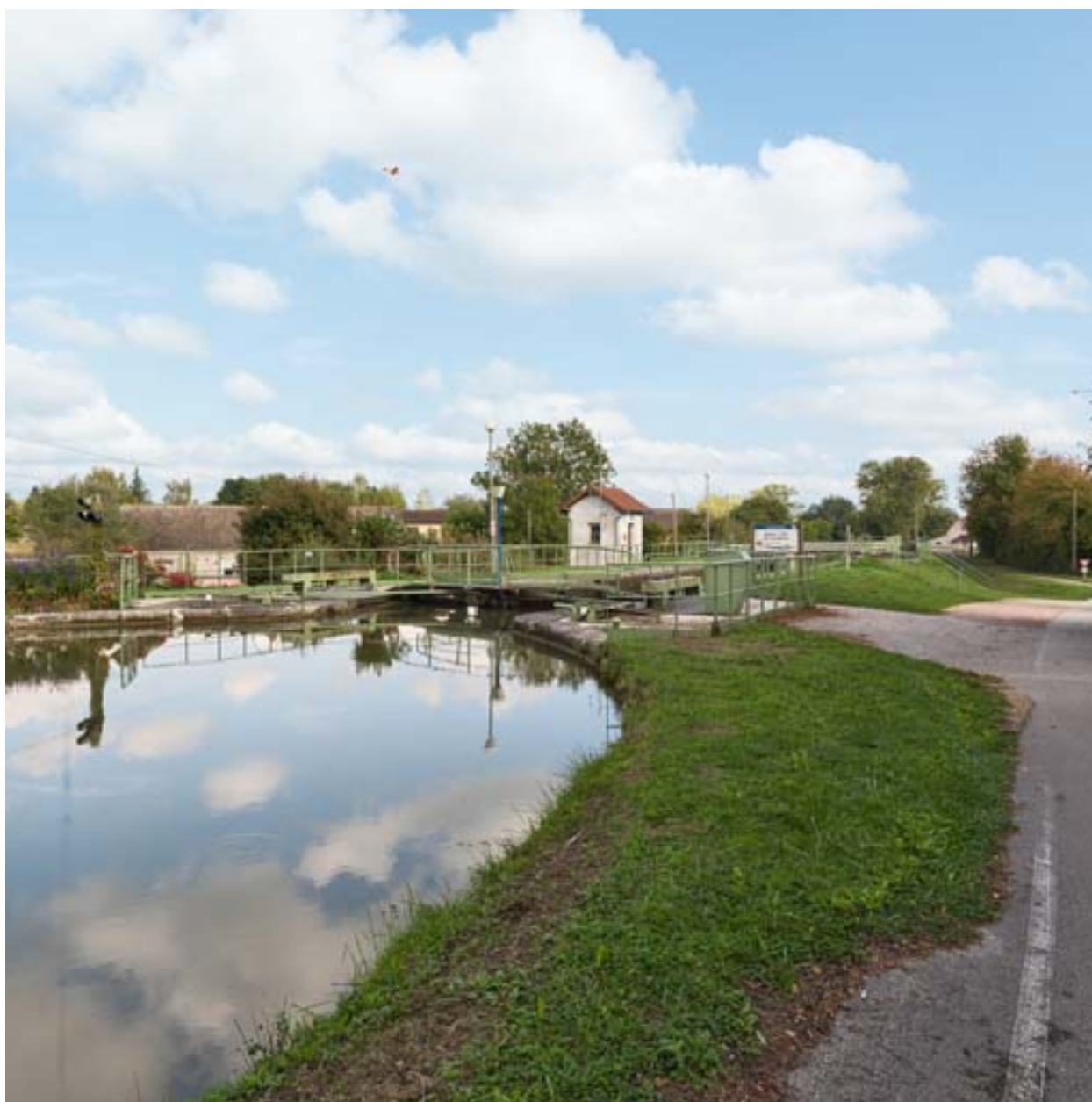
Vue d'ensemble du site d'écluse.
