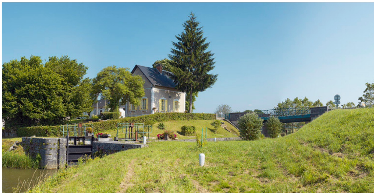
Pont sur l'écluse.
