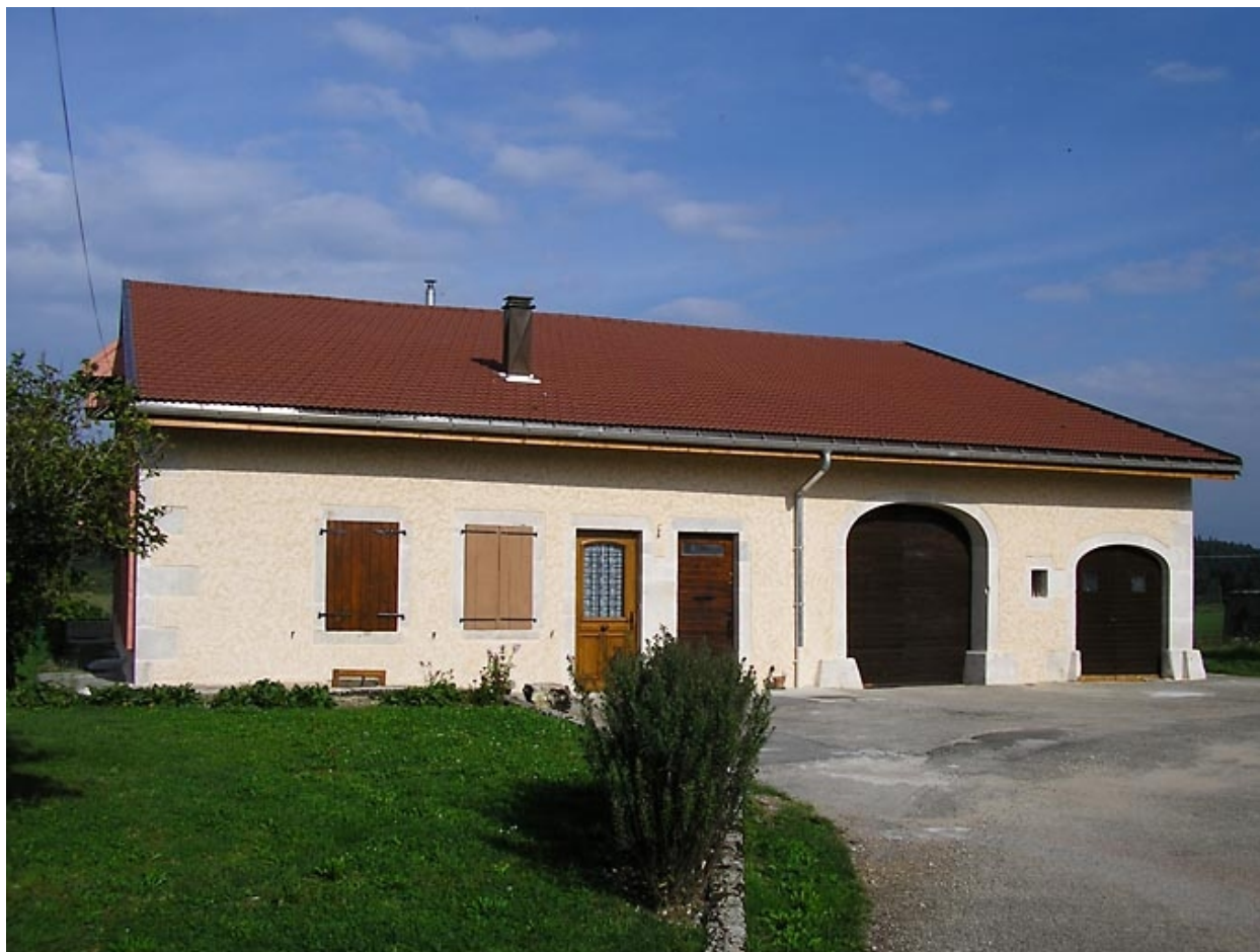
Vue latérale de la façade antérieure.
