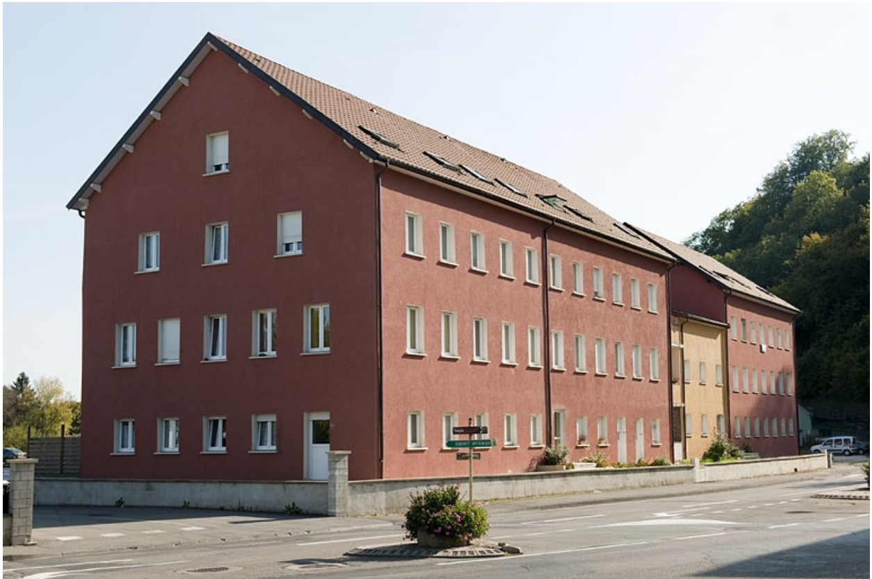
Ateliers de fabrication vus depuis le nord-ouest.
