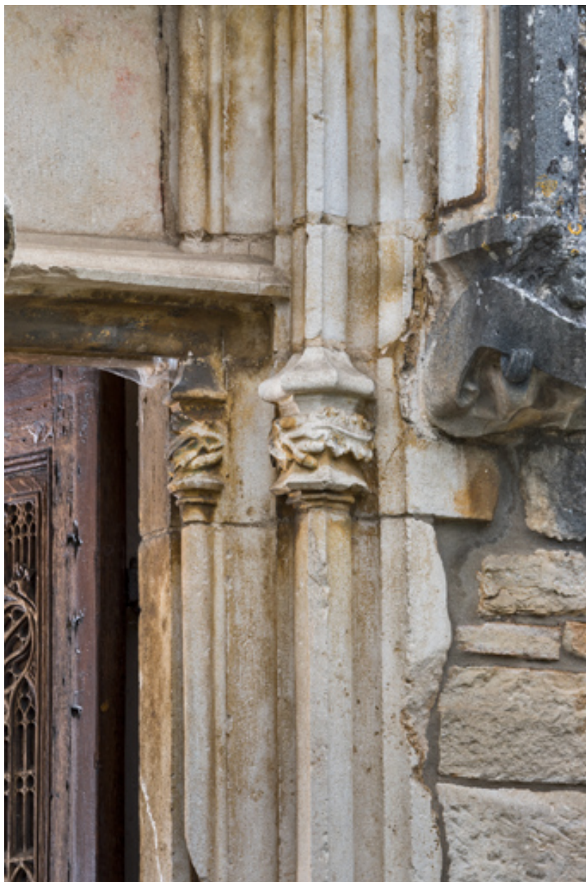
Piédroit, détail de la partie supérieure, droite.
