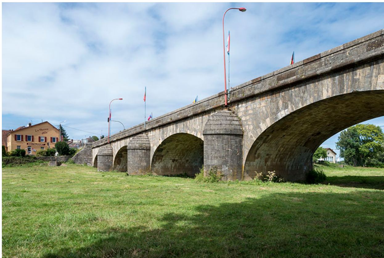
Vue depuis l'aval.
