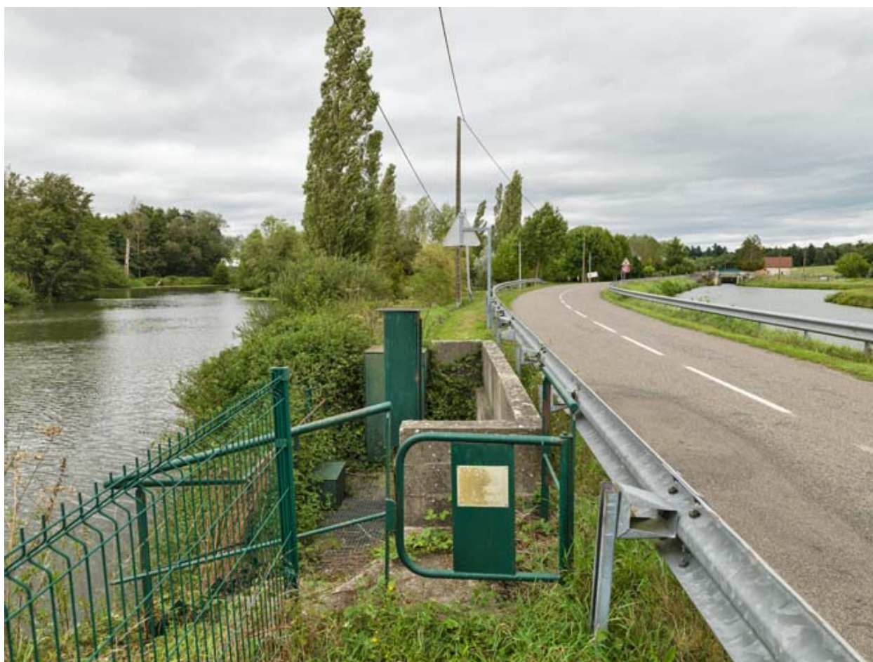
Vue de l'aqueduc.
