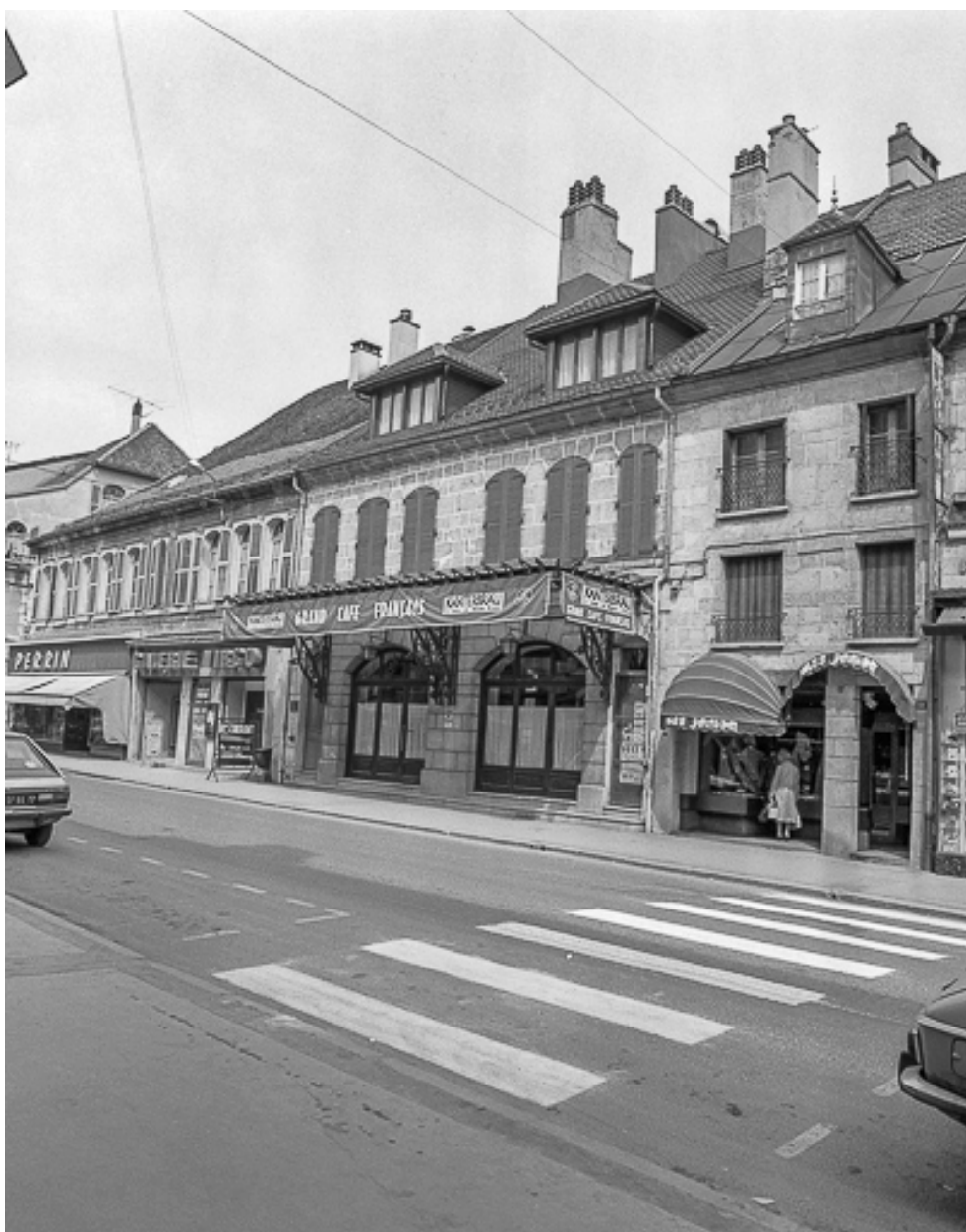
Maisons situées 34 à 38 rue de la République.
