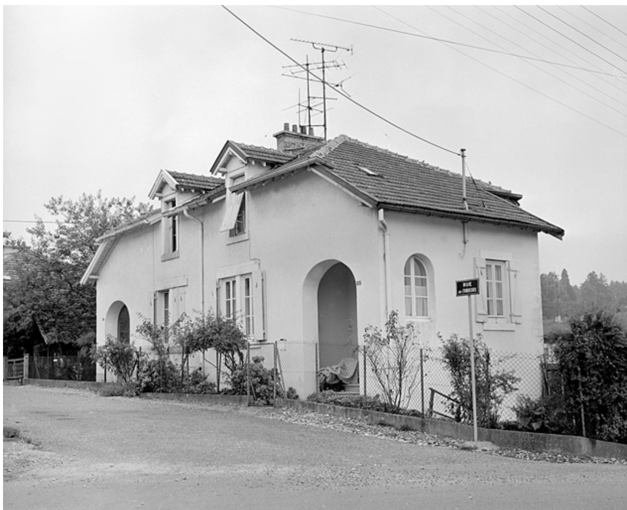
Maison jumelée rue des Fondateurs.SRI. Enquête régionale sur les bâtiments industriels (1979-1981).
