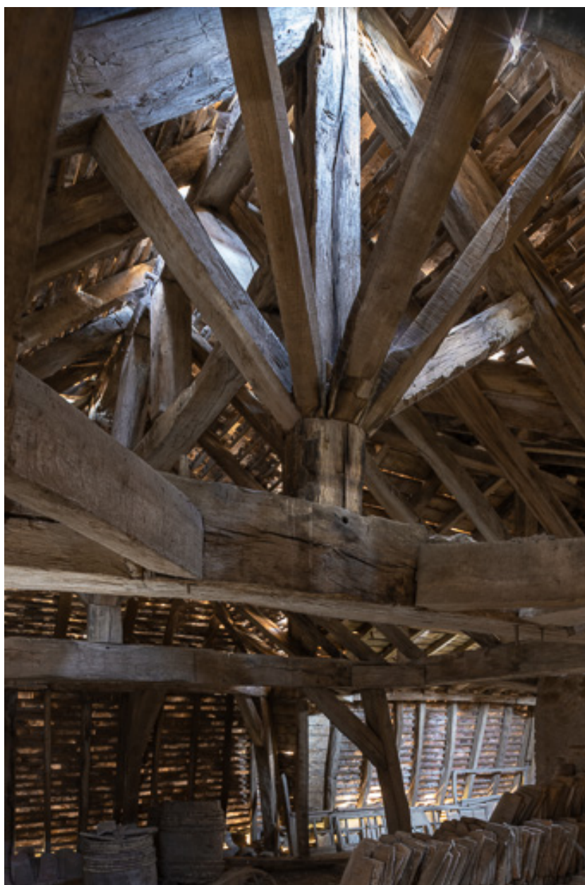
Détail de la charpente : pignon et contrefiches
