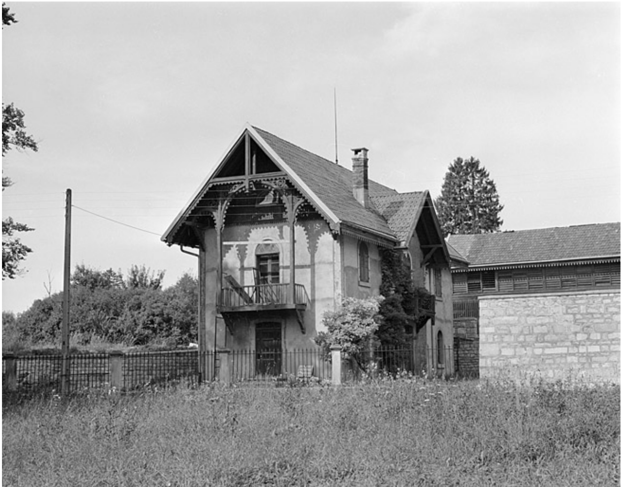
La conciergerie depuis le sud en 1981.SRI. Enquête régionale sur les bâtiments industriels (1979-1981).
