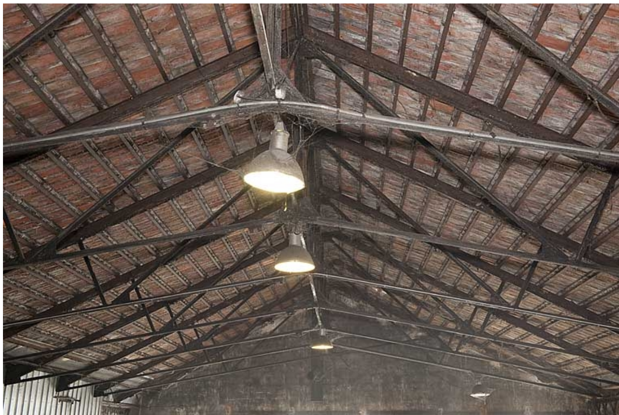
Charpente métallique d'un magasin industriel.
