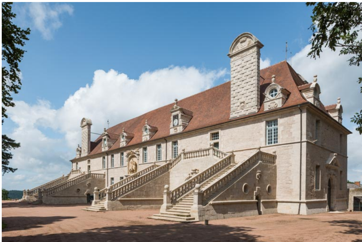
Façade sud-est, vue d'ensemble depuis l'est.
