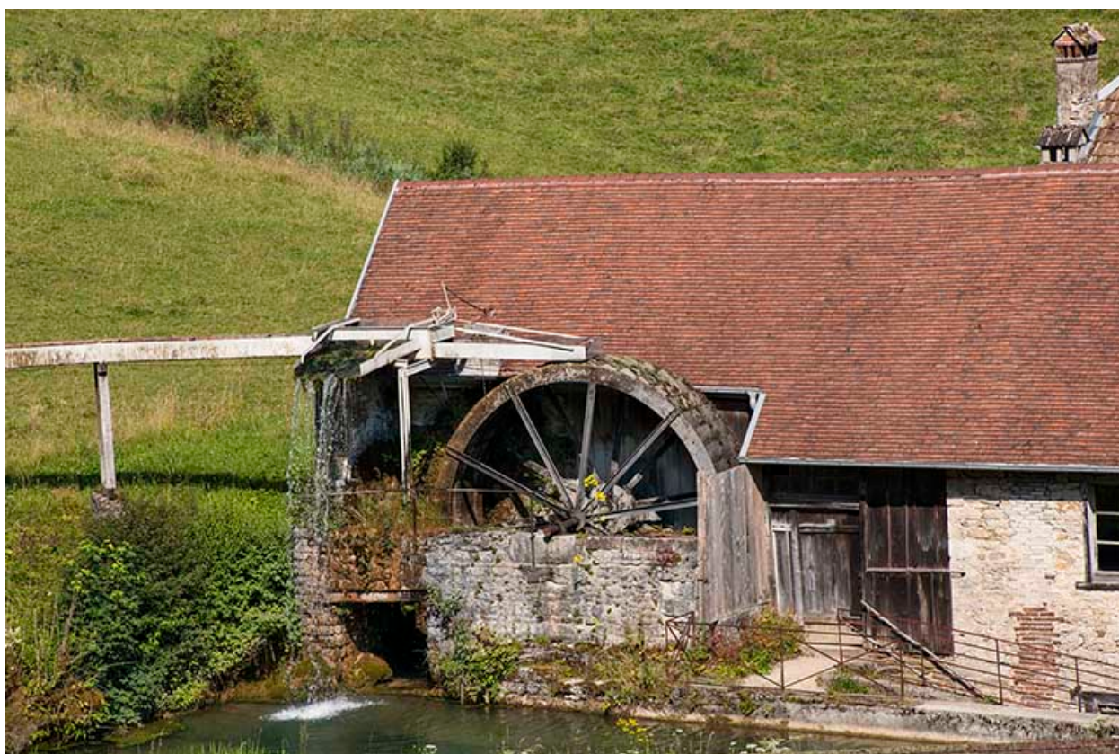
Roue hydraulique de la machine soufflante.
