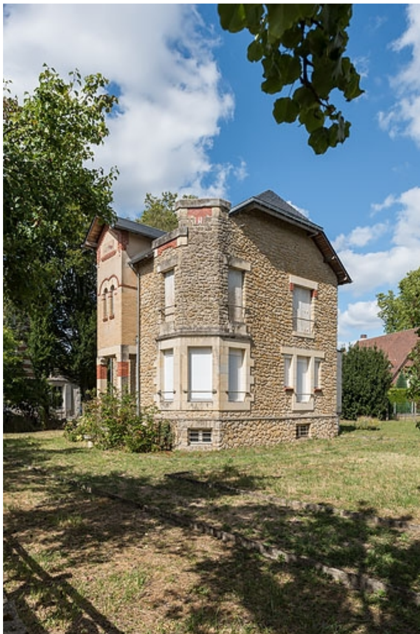
Vue depuis le sud-ouest.
