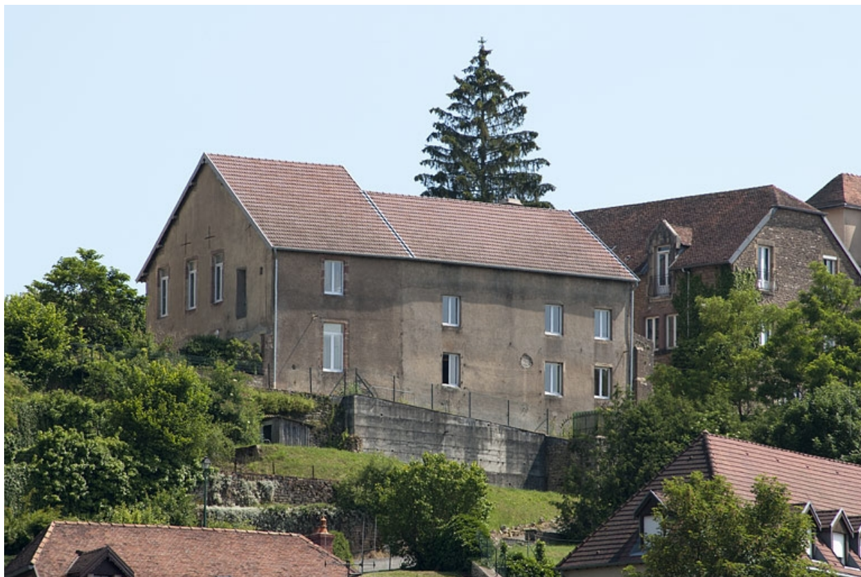
Bâtiment (B), vue générale côté village.
