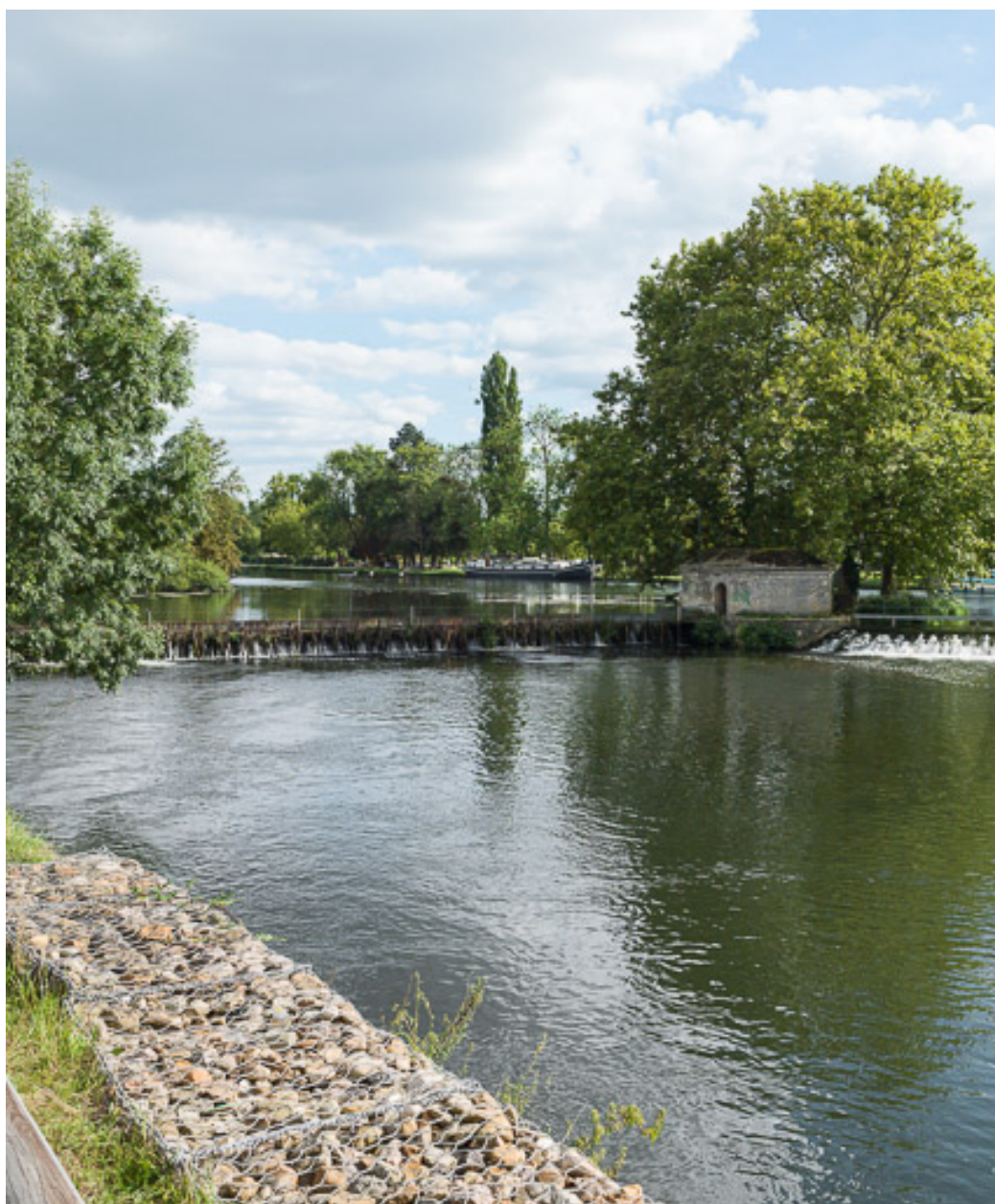
Vue du barrage.
