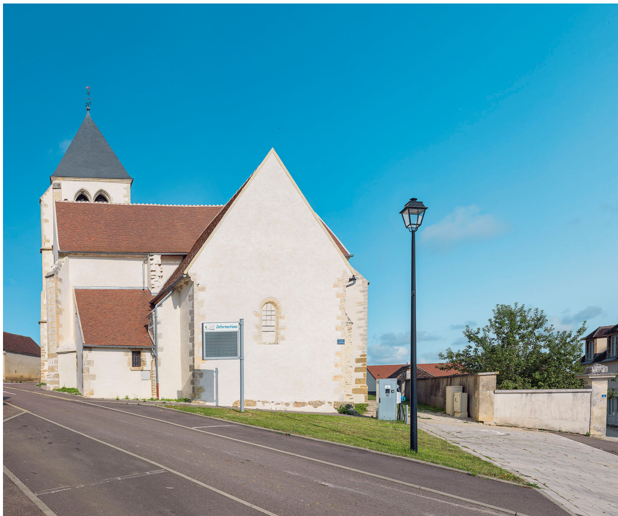
Vue d'ensemble depuis le chevet.
