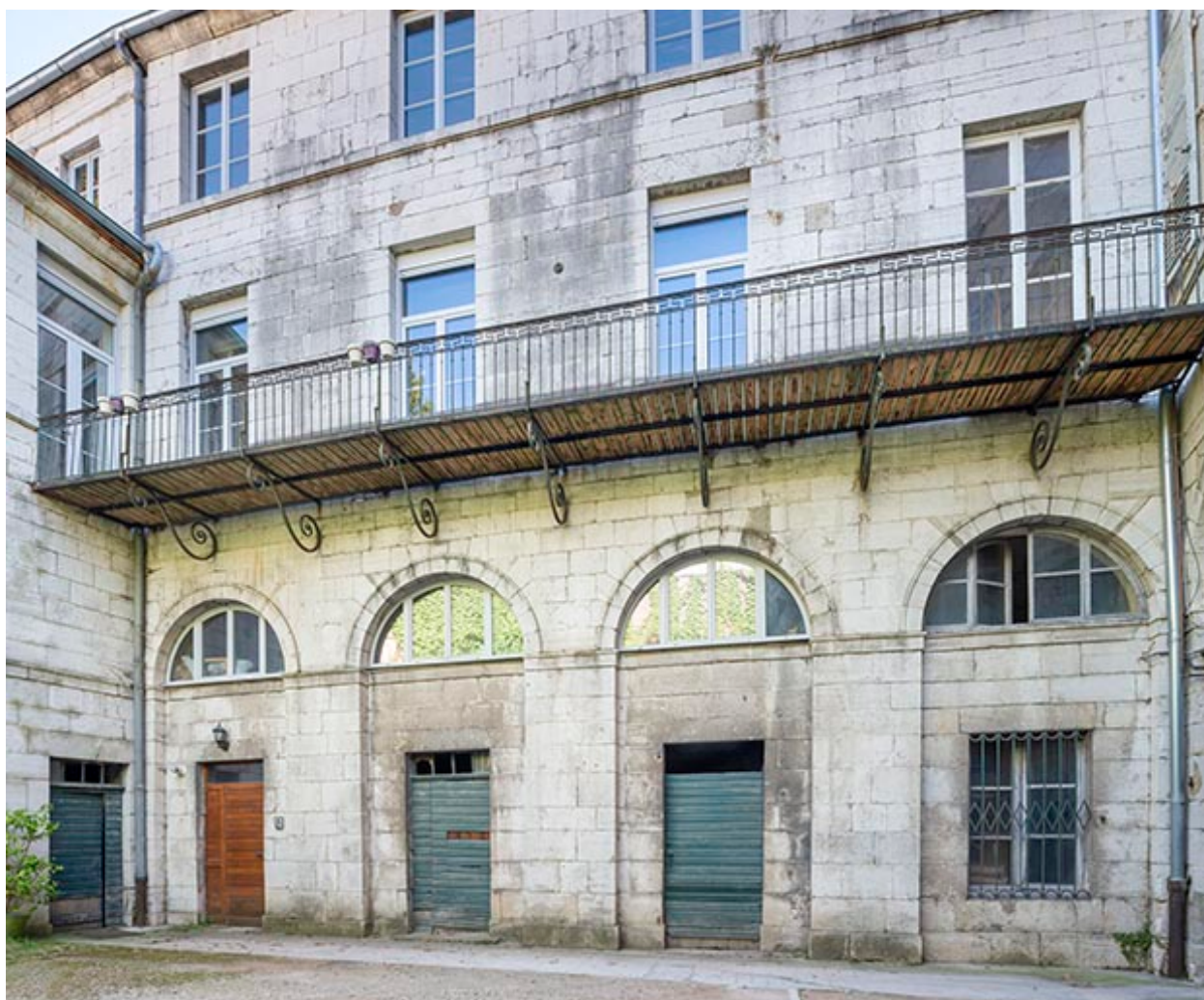
Façade de l'aile sud, depuis la cour.
