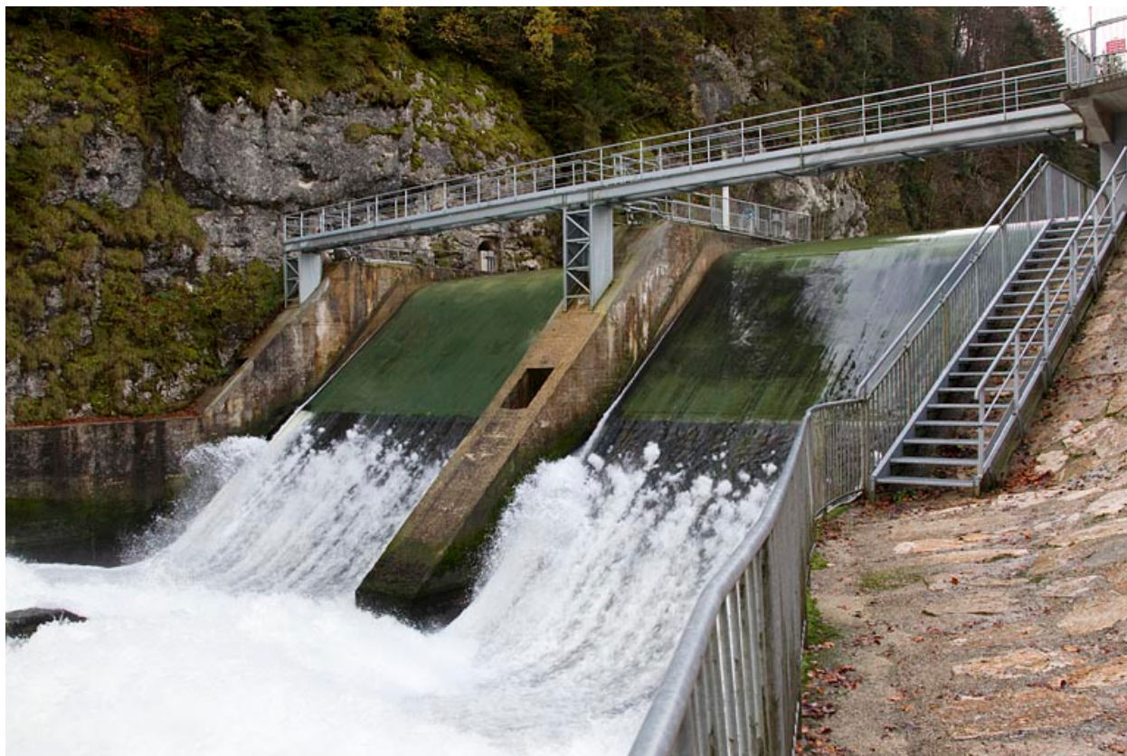
Barrage vu de trois quarts, depuis l'aval.
