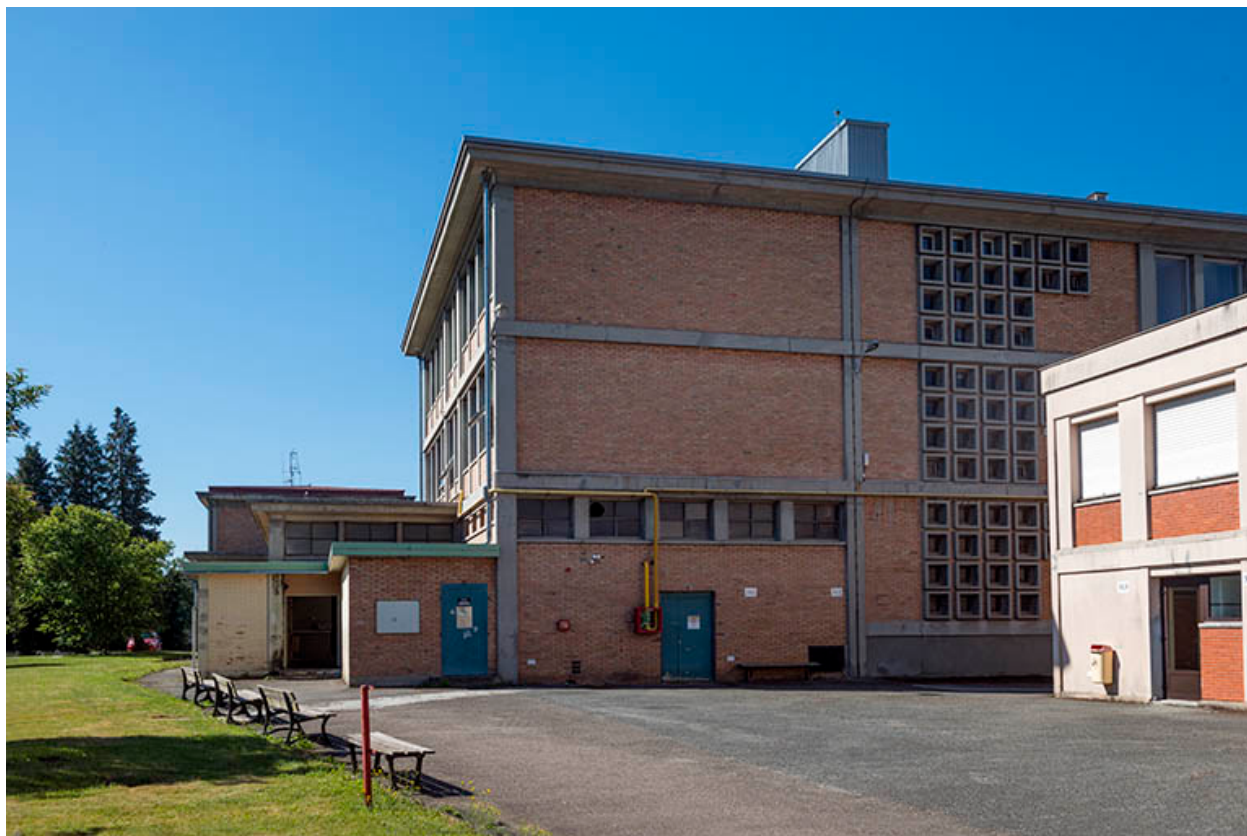
Façades antérieures (nord) du bâtiment d'externat. (ex-Garnier)
