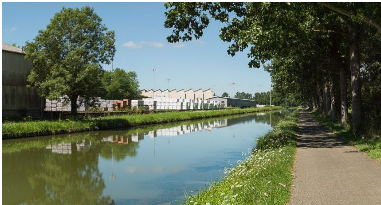
Vue d'ensemble d'amont.
