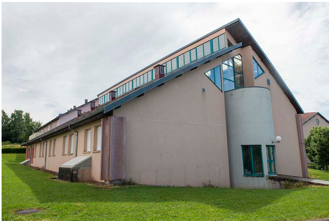
Pignon ouest de l'internat sud-ouest.
