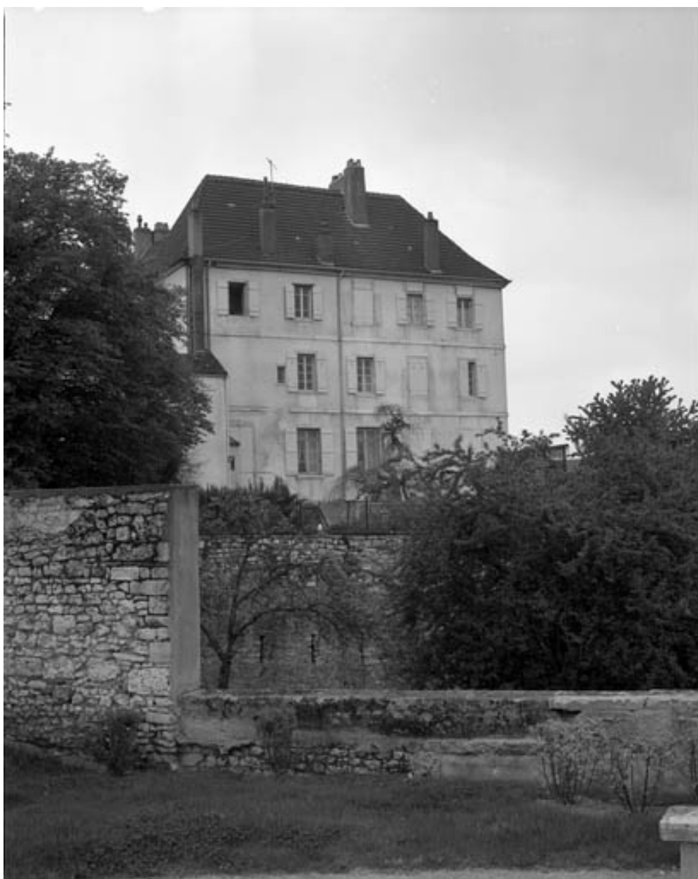
Façade latérale du bâtiment principal.
