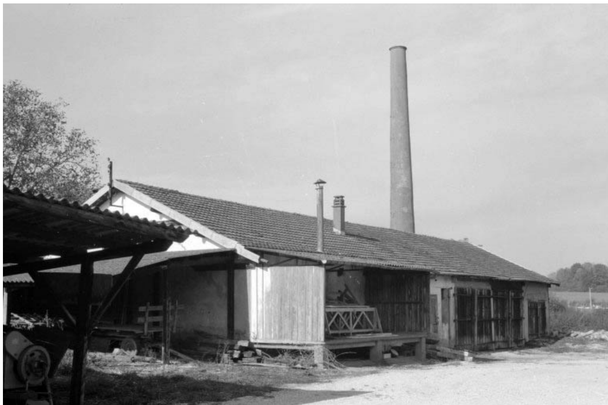
Hangar (C), remise (B) et cheminée d'usine.
