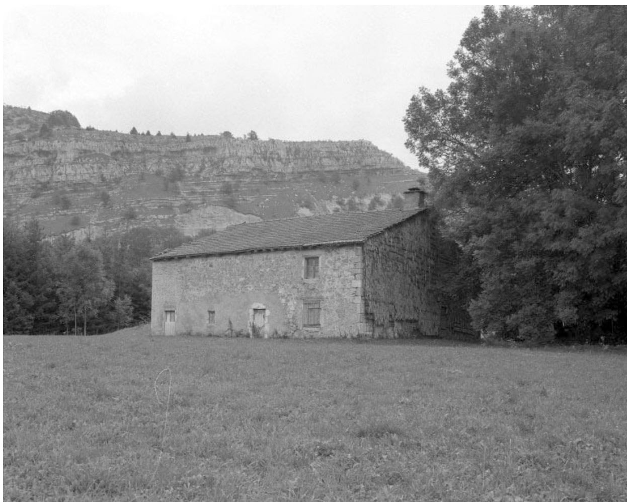
Façade postérieure et face gauche recouverte d'un essentage de tavaillons.
