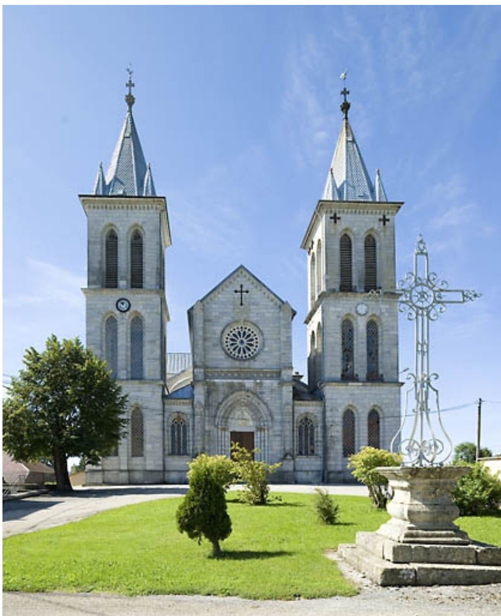
Façade antérieure et croix monumentale.
