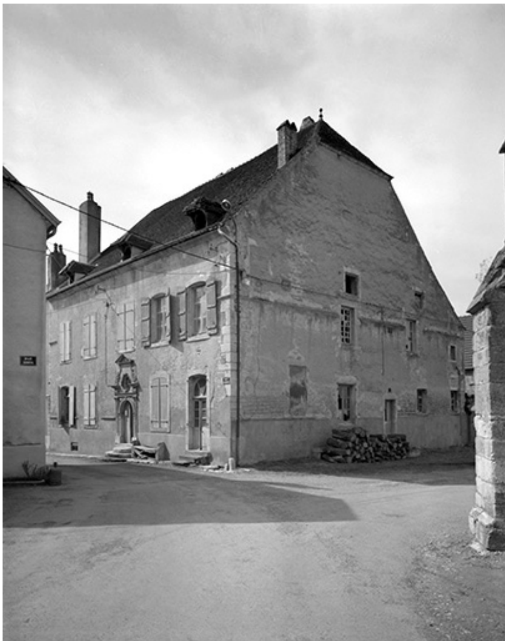
Maison située 1 rue de Granvelle : vue d'ensemble.
