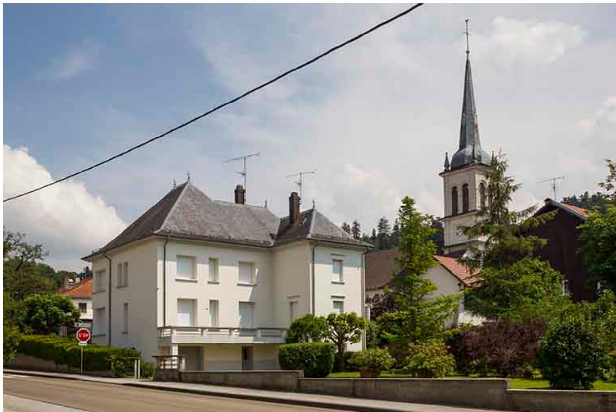
Logement patronal depuis l'ouest (façade postérieure).
