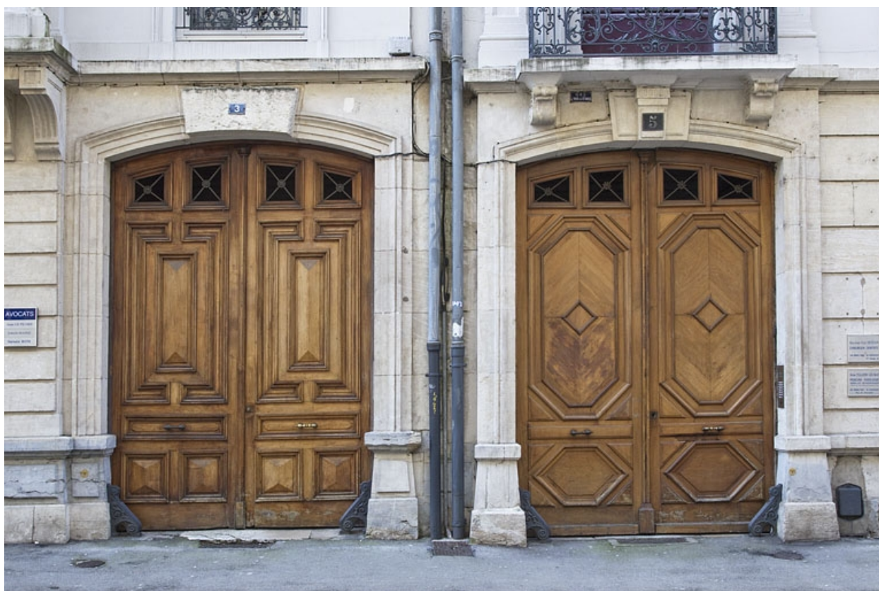
Façade antérieure : détail du portail d'entrée.
