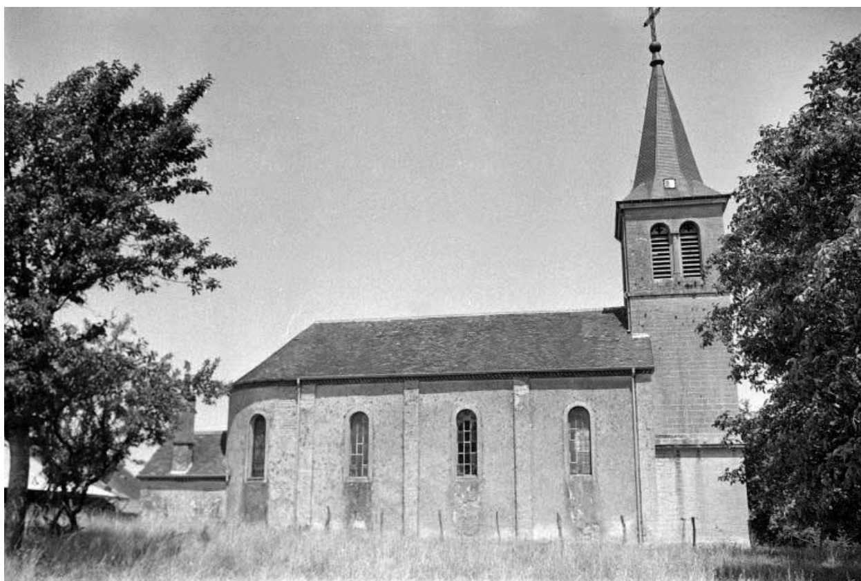
Façade latérale gauche : vue rapprochée.
