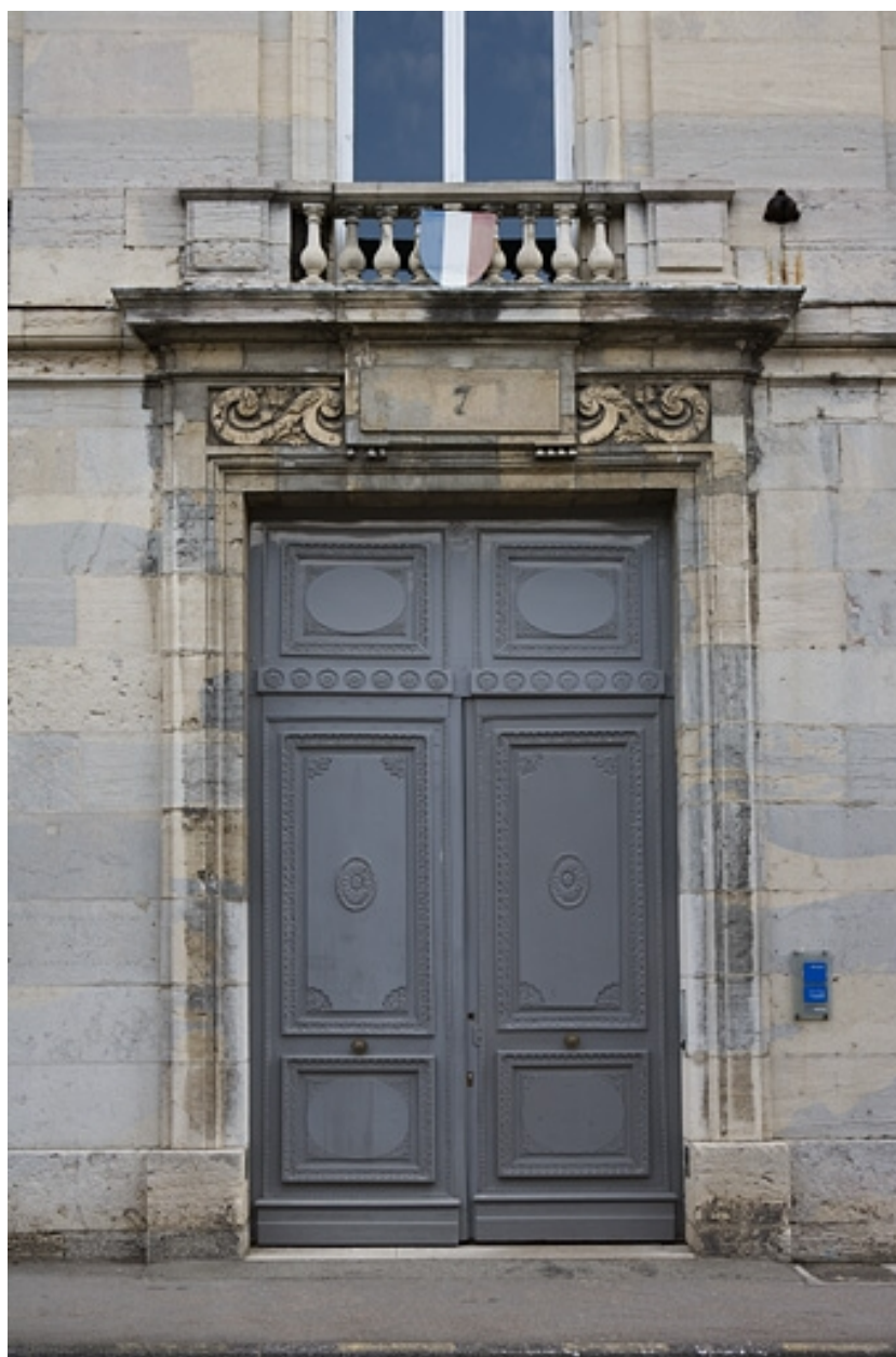
Détail du portail d'entrée.
