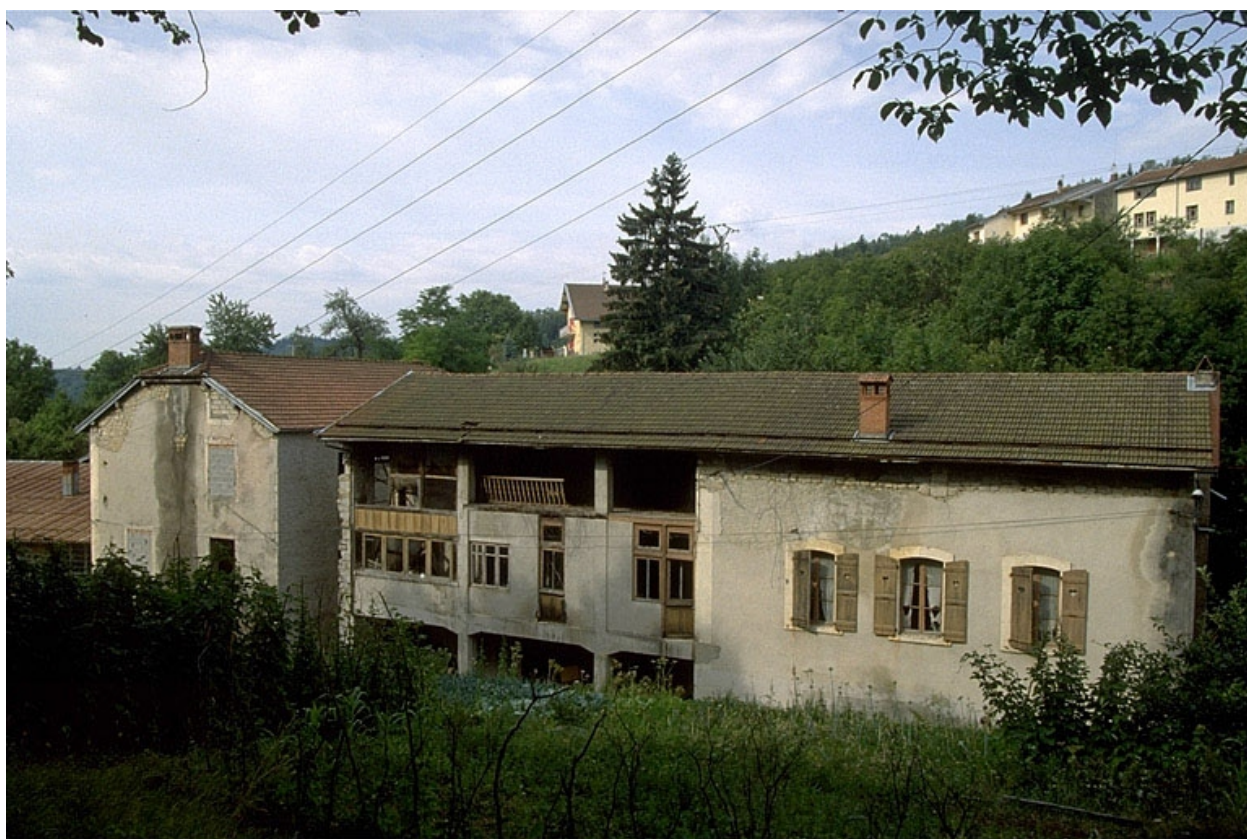
Ancienne tournerie, atelier de fabrication et logement.
