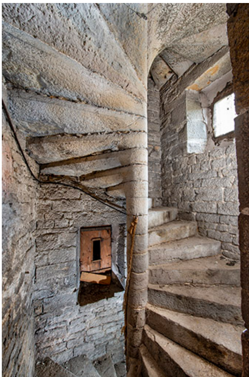
Escalier en vis de la tour.
