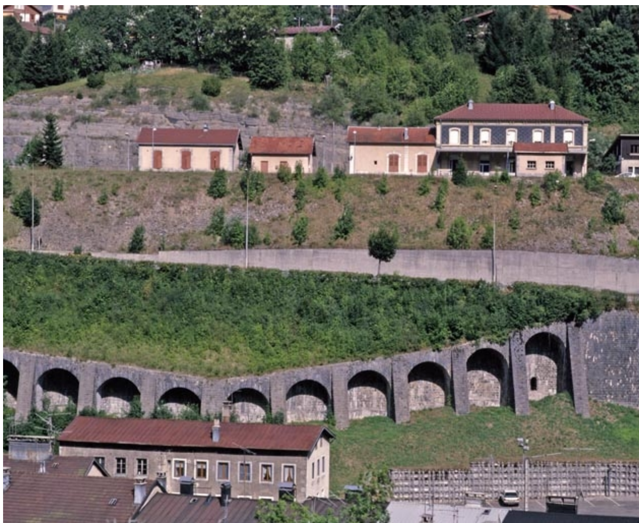
Bâtiment des voyageurs et logement, depuis l'ouest.
