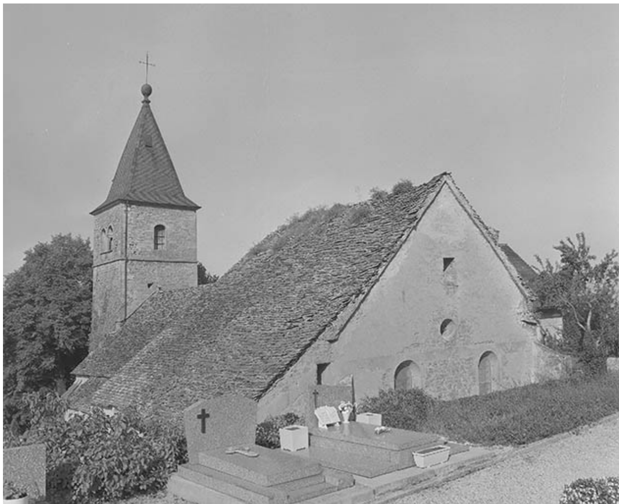
Façade latérale droite et chevet.
